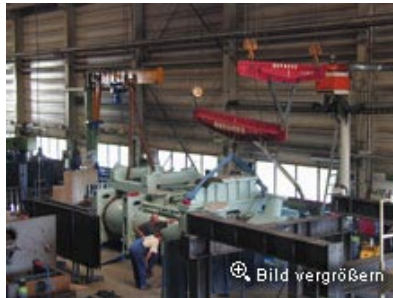
Änderungsarbeiten an Compounder 30 Tonnen Lackierung in RAL 6019
