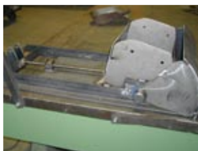
Neuanfertigung von Siloklappe mit Schieber nach Muster
